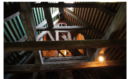
Dachtragwerk Siechenhaus Foto: D. Dragin
