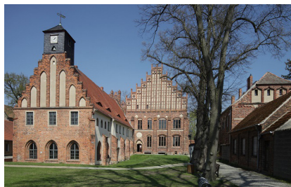
Außenansicht Foto: D. Dragin
