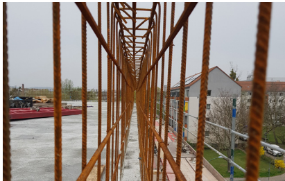
Bewehrung Brüstung DG Foto: 2BPlan
