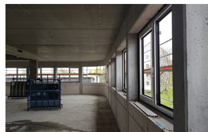
Rohbau Bürofläche April 2017 Foto: 2BPlan
