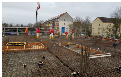
Bauzustand Decke ü.EG 2017 Foto: 2BPlan
