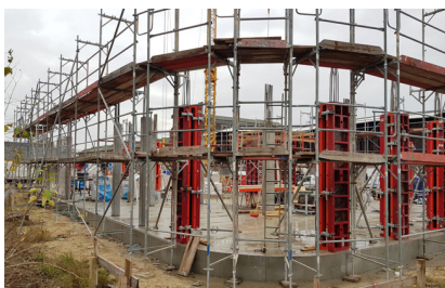
Bauzustand Nov. 2017 Foto: 2BPlan
