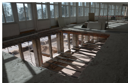
Sanierung der bauzeitl. Ziegeldecke 04.2019
