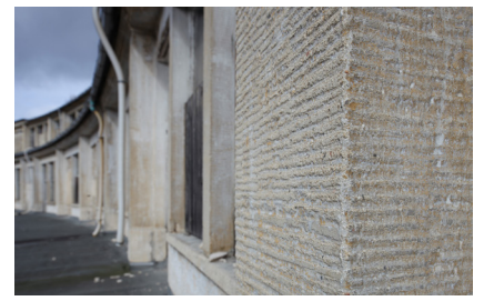
Fassadendetail Foto: D. Dragin
